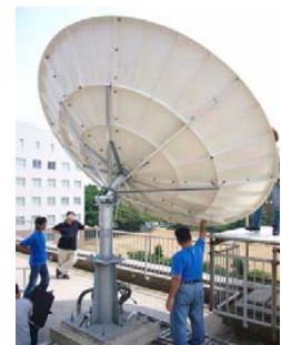
図8. 地震研究所に設置されているMTSAT受信アンテナ(直径3.8m)。
