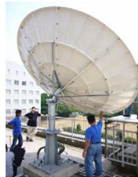
図4 地震研究所に設置されている MTSAT 受信用アンテナ(直径 3.8m).
